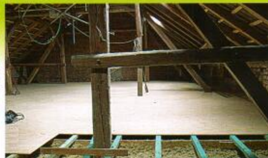
Do nové stropní konstrukce byla aplikována izolace a je montována dokonale rovná nová podlaha z desek.
