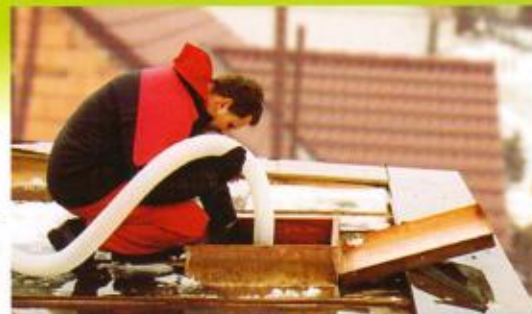
U pultových střech doporučujeme vždy osadit vikýř, je výhodný pro samotnou izolaci a jako revizní vstup do prostoru střechy.
